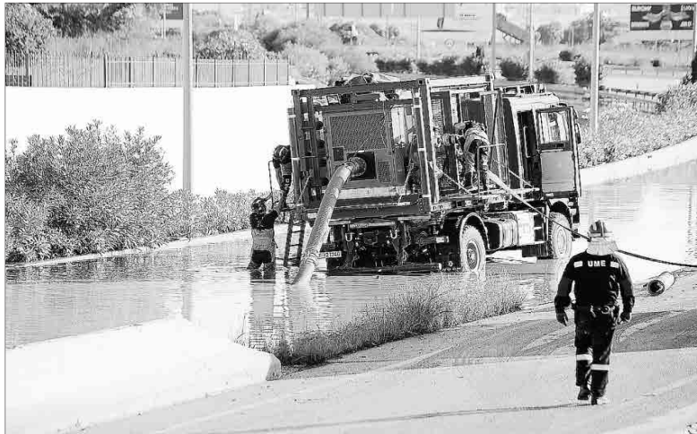
Una de las bombas de gran caudal actuando ayer por la mañana en la carretera del aeropuerto. Foto: M. COPA
